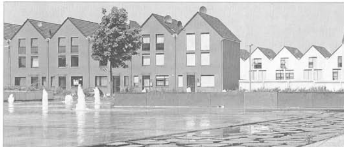
Die Kalkulation ist aufgegangen, der unternehmerische Mut belohnt worden. Zum Jahresende will die Quadflieg GmbH rund 170 Wohneinheiten im Annapark fertiggestellt haben – im Bild die jüngste Hauszeile am „Wassertisch“ nahe beim Fördergerüst. An anderer Stelle geht es schon weiter mit neuen Bauvorhaben.
